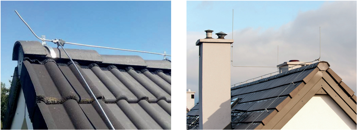
Держатели коньковые предназначены для крепления круглого проводника вдоль коньков крыши имеющих различную форму профиля
